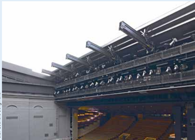
Die 5 ausfahrbaren Teleskopträger für die Dachsegmente
